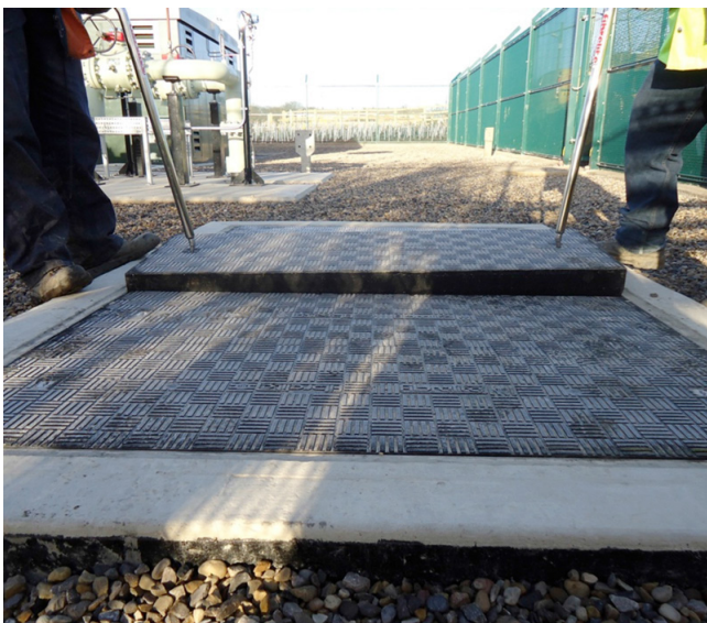
Les trappes sont retirées facilement grâce à la poignée de levage FL7A
