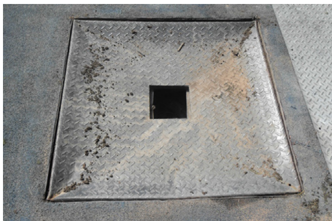
Finis avec le vieux : les tampons en acier endommagés vont être remplacés par les trappes d'accès Fibrelite
