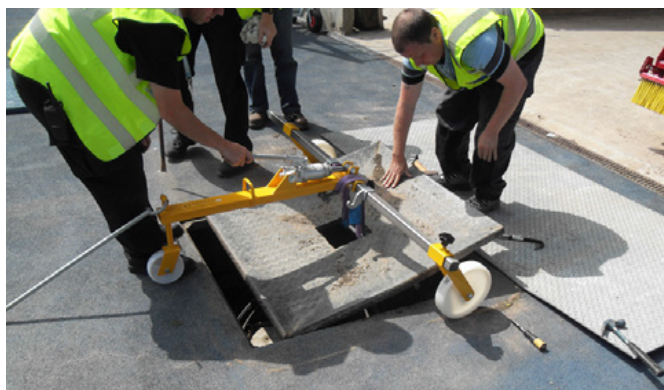
Manipulation manuelle : l'installation précédente requérait un poussoir hydraulique pour déplacer le tampon
