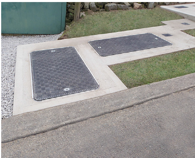
Aperçu de l'installation des tampons légers d'une capacité de charge de 25 tonnes Fibrelite
