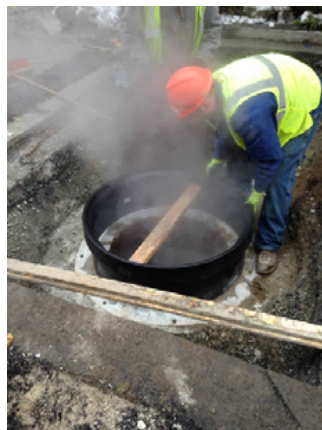
Les installations Fibrelite sont simples : une jupe en fibre de verre peut être utilisée afin de fixer le cadre à un niveau adéquat.
