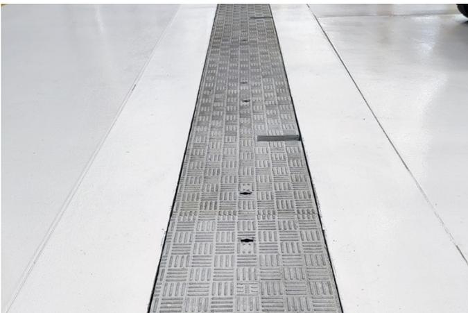
*La classe E600 'Super Heavy Duty' était essentielle pour supporter le passage fréquent des avions sur la tranchée*
