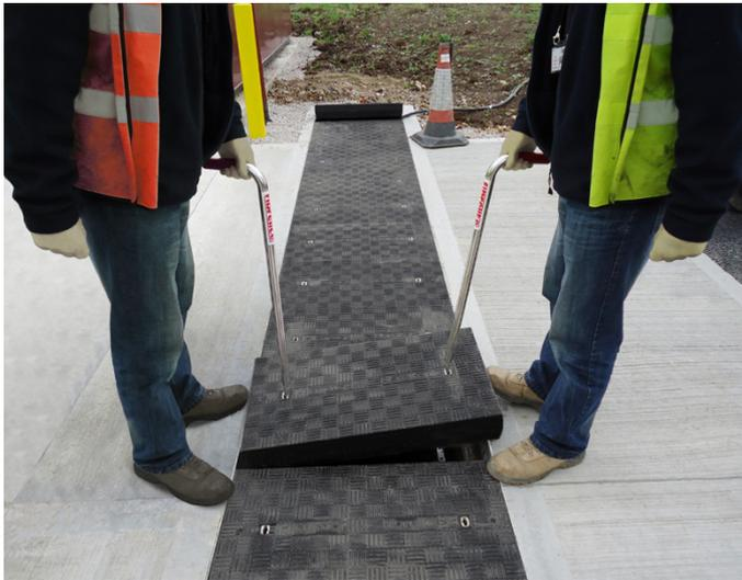
Tous les panneaux Fibrelite peuvent être retirés en toute sécurité et rapidement par deux personnes à l'aide des poignées de levage FL7 (image utilisée à des fins d'illustration et montre une installation différente)
