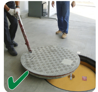
Manipulation en toute sécurité avec la poignée de levage Fibrelite
