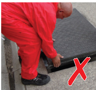
Technique dangereuse sans la clé de levage Fibrelite
